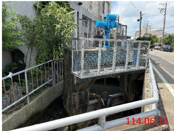
114年6月11日嘉盛五張犁第三號排水門現況
