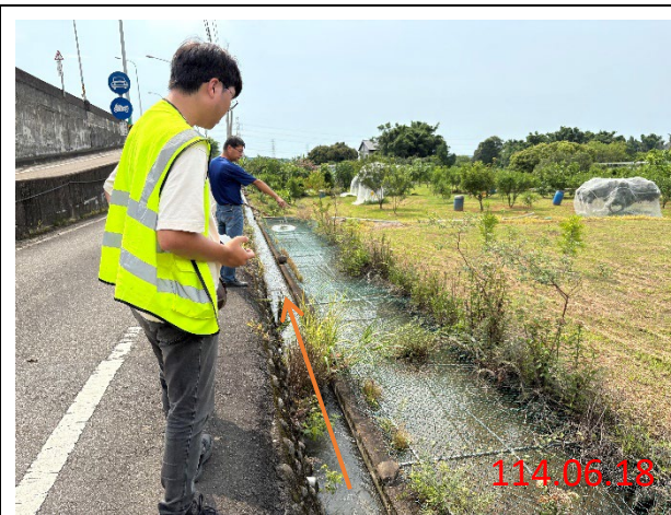
時間：114年6月18日 說明：七十份圳5支線現勘
