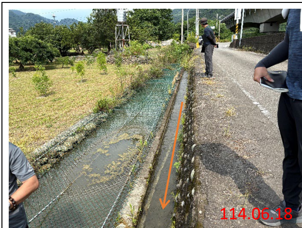
時間：114年6月18日 說明：七十份圳5支線現勘
