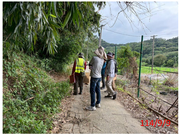
說明：農田水利署苗栗管理處引導與會者勘查牛欄肚圳現有暗渠情形。
