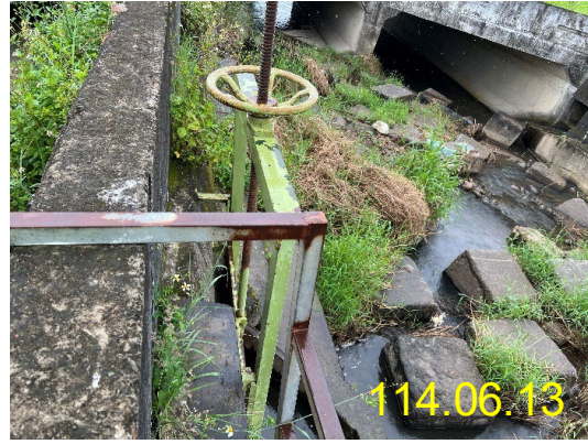
114年6月13日伯公圳第1支線水門取水口現況
