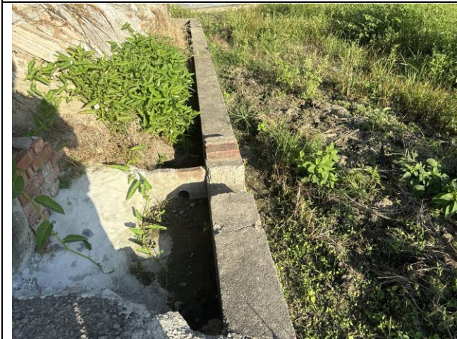
說明：工區 6-1 保留既有涵管處(上田灌溉用)。
