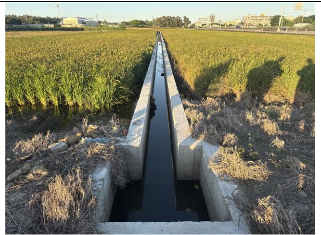
說明：吳站長表示，改善後會像上游已完工段，將渠道拉直，但仍會持原有斷面寬度與高度。
