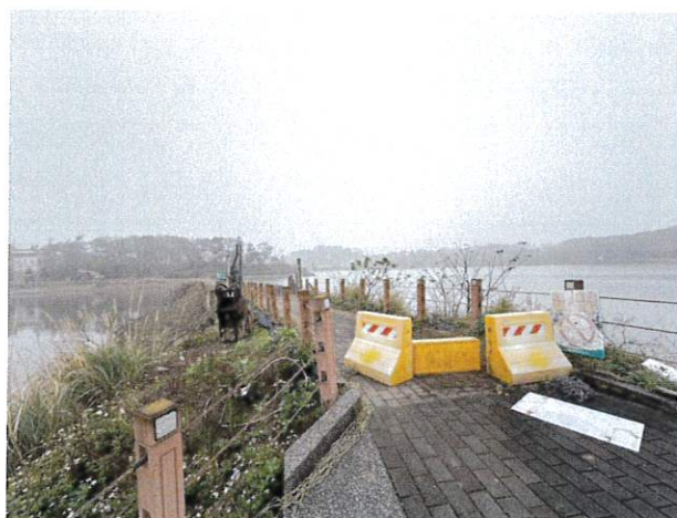
說明：已設置護欄
