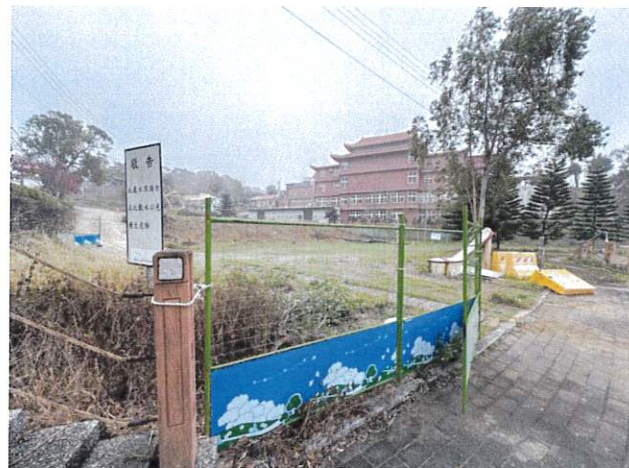
說明：已設置圍欄
