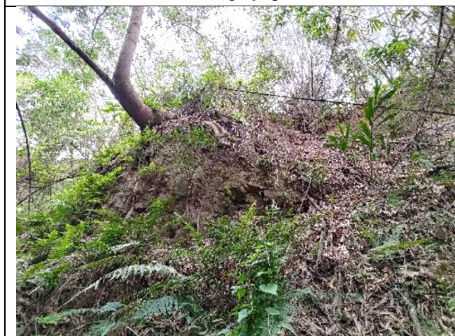
說明：隧道周邊次生林
