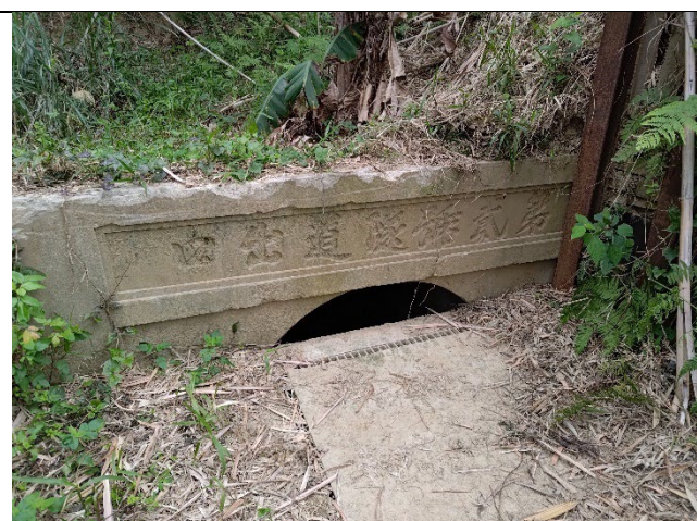
說明：二號隧道段出口
