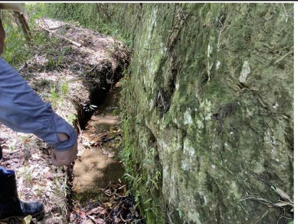
說明：B0k+129 大窩雅悠圳部分區段為土溝，漏水嚴重偉水源流失
