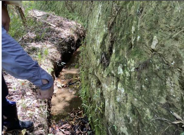
說明：B0k+050 大窩雅悠圳部分區段為土溝，漏水嚴重偉水源流失
