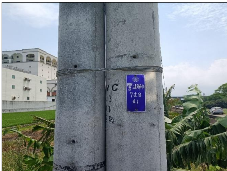
水尾大排(台電電桿編號：豐湖幹 7 支 8 支 1)
